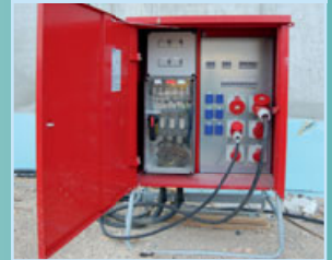
Baustromverteilerschrank
