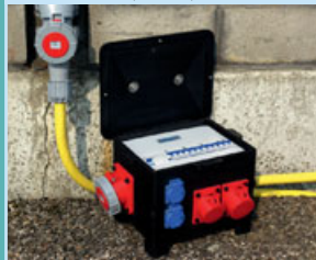
Stromverteiler mit Steckdosen (mobil)
